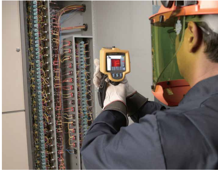
비정상적으로 고온인 전기 연결부가 있다는 것은 고장 및 안전 사고 위험의 조기 경고일 뿐 아니라, 과도하게 많은 에너지를 소비하고 있음을 나타내주는 지표이기도 합니다.
